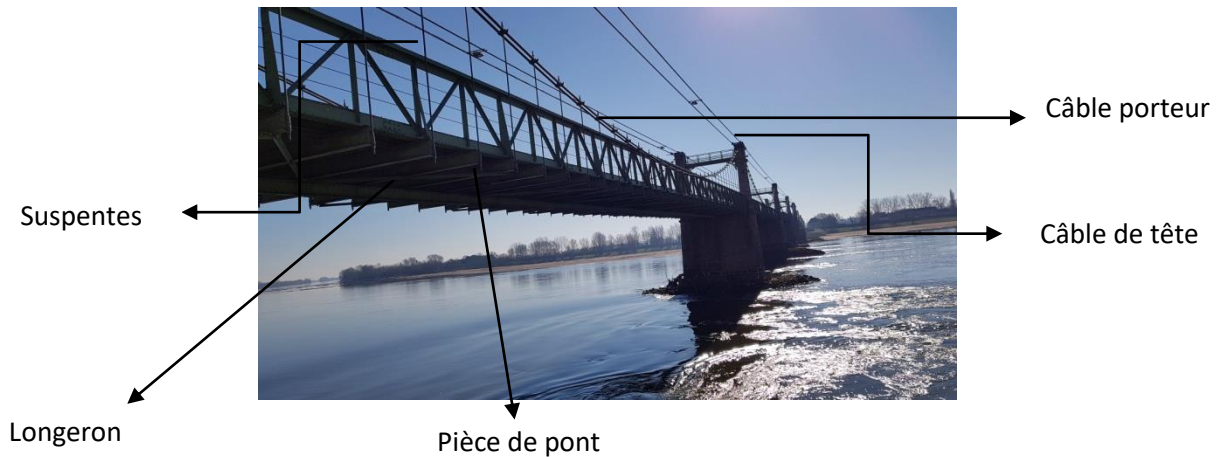
Figure 8 : visualisation des éléments du pont suspendu de l'INGRANDES
