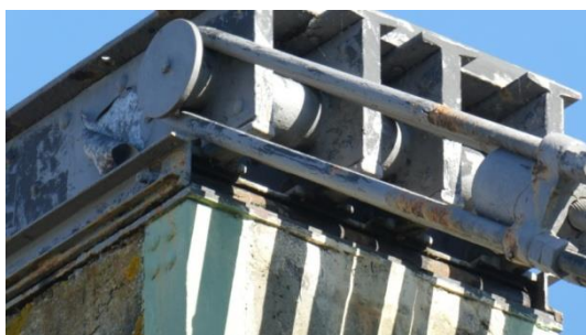
Figure 10 : selle des appuis de rive
