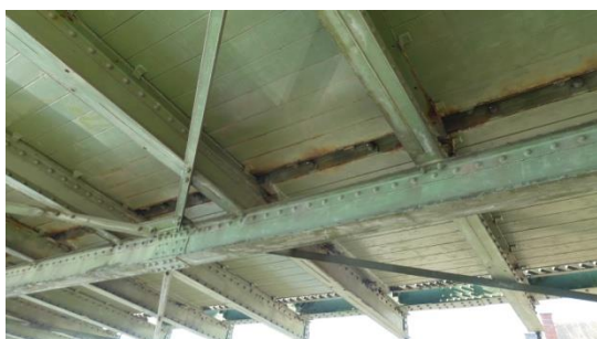
Figure 12 : contreventement dans les travées BAUDIN
