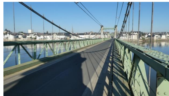
Figure 13: superstructure et tablier travée BAUDIN
